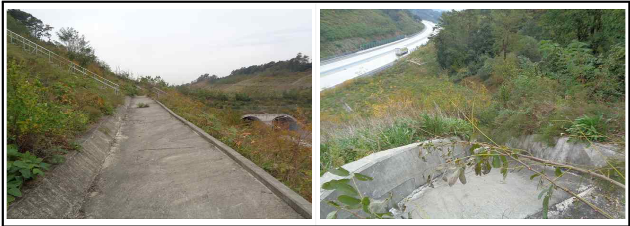
【그림 6.3.3】 배수시설 전경
